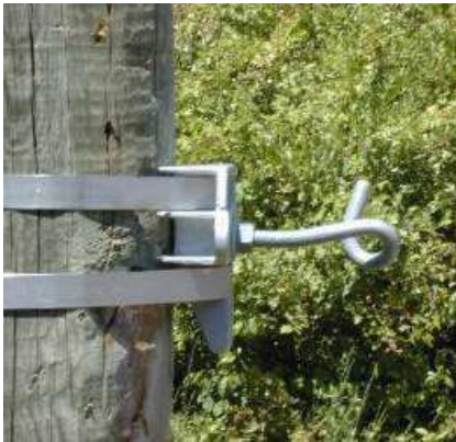
Fixation de la semelle par cerclage + queue de cochon
