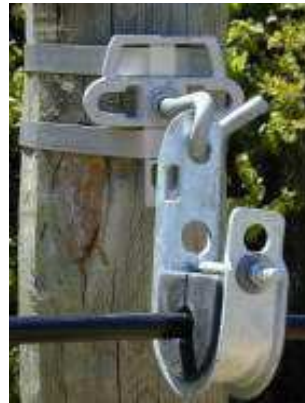
Fixation sur poteau via dispositif de suspension en J et queue de cochon
