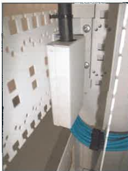
Illustration -- Exemple d'équerre d'arrimage du boîtier éclateur
