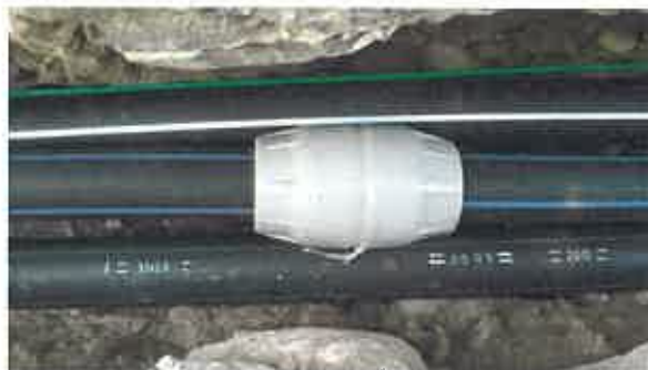
Exemple de manchon pour le raccord de tubes PEHD
