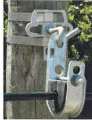
Fixation sur poteau via dispositif de suspension en J et queue de cochon
